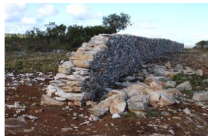
Parede em construção
